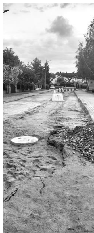
Prace przy ul. Akacyjnej
