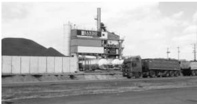
Fabryka masy bitumicznej
