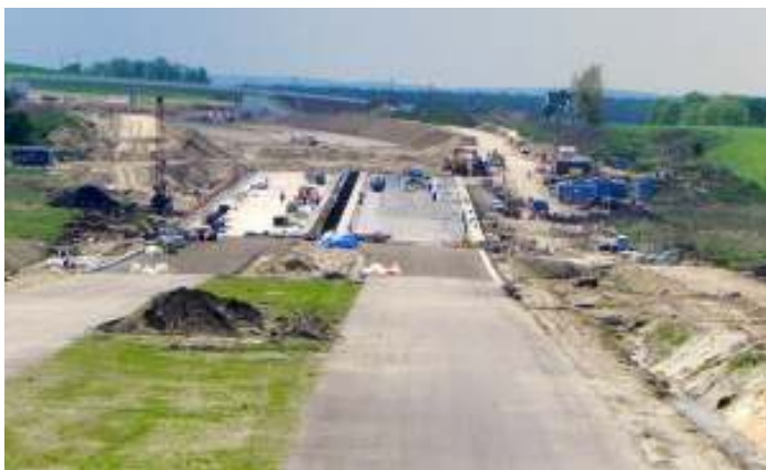
Prace przy estakadzie, w oddali - przejezdny już wiadukt w Wilkowie
