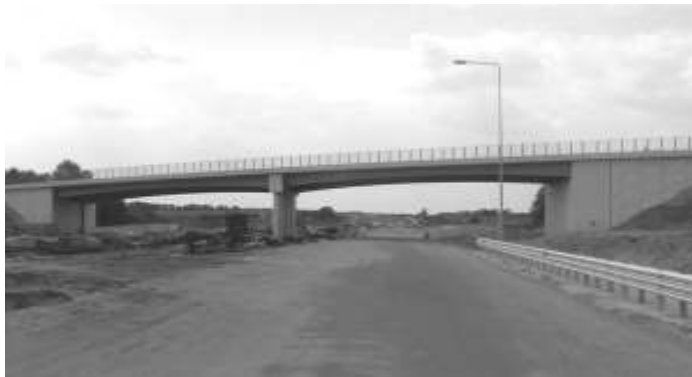
Wiadukt przy ulicy Leśnej
