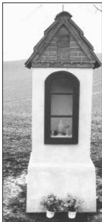
Wyremontowana kapliczka z funduszy powiatowych
