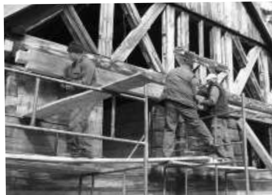
Olsztynek, remont chałupy z Bartężka, 2011 r., /fot. Archiwum MBL- PE
