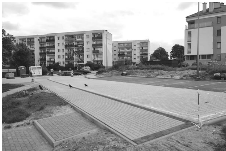
Przebudowa odcinka ulicy Kolejowej / fot. UM Olsztynek
