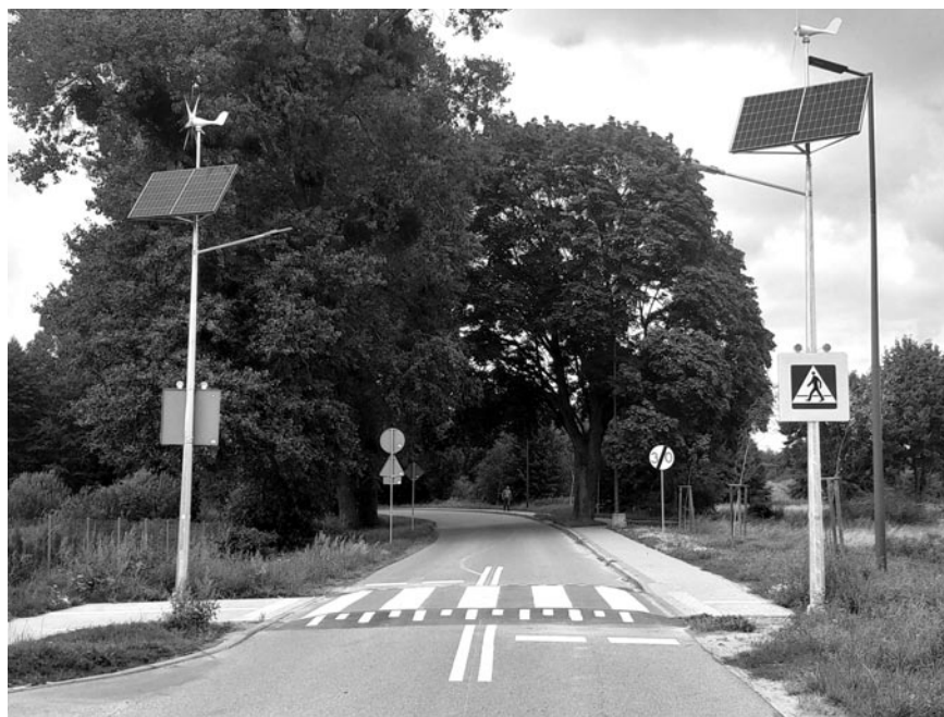
Przebudowane przejście dla pieszych na skrzyżowaniu ulic Jemiółwskiej i Wędkarskiej / fot. UM Olsztynek
